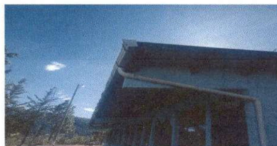
Foto 2: sustitucion de canales de metal modulo de aulas
