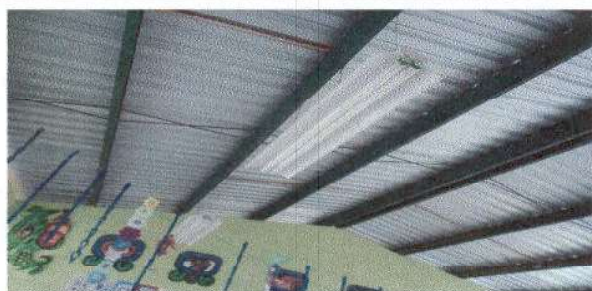
Foto 5: Reparación de lampara modulo de aulas
