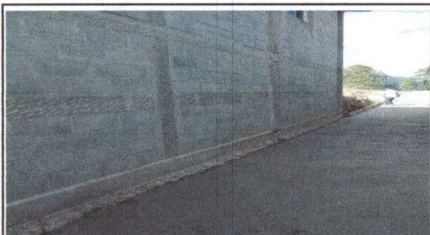
Foto 3: reparacion de plancha de concreto de patio
