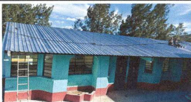
Foto1: sustitucion de Lamina troquelada aluzinc caibre 26 modulo de aulas
